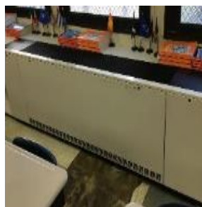
TCU Unit Ventilator
