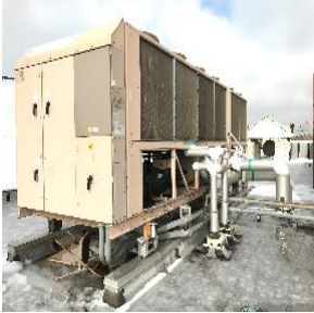
207-ton York Chiller
