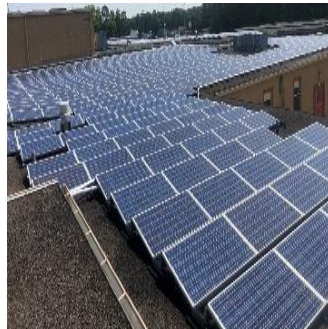
Rooftop Solar PV Array
