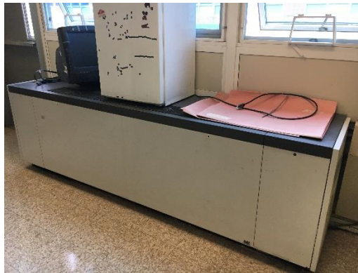
Newer Unit Ventilator (UV)
