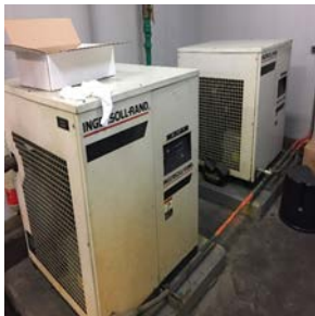
15hp Air Compressor
