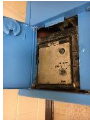
Fan Coil Unit
