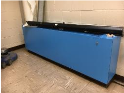
Fan Coil Unit
