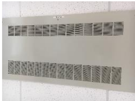
Fan Coil Unit
