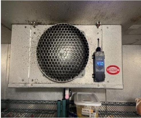
Refrigerator Evaporator Fan
