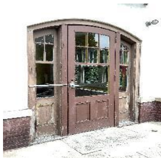
Sun Porch Door
