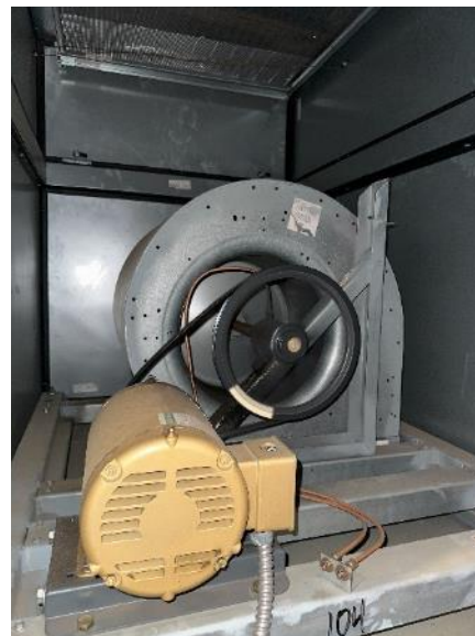
AHU-1 Supply Fan Section
