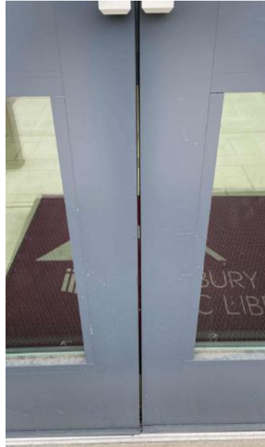
Solid Metal Door & Door Seal Gap
