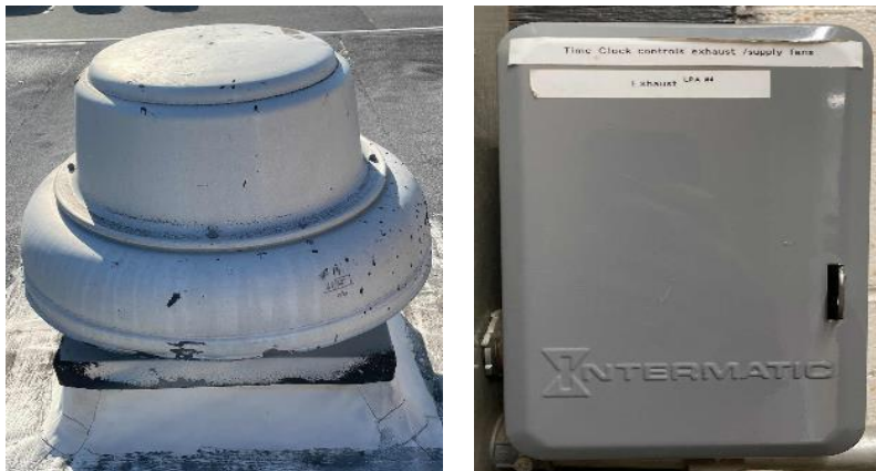
Exhaust Fan Timers
