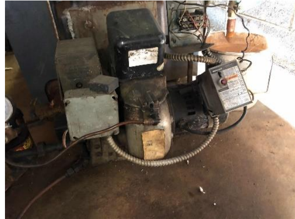
Combustion Air Fan
