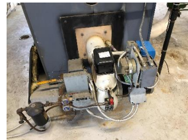
Combustion Air Fan
