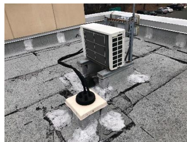
Ductless Mini Split Outdoor Unit
