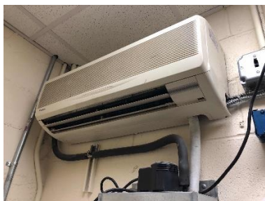
Ductless Mini Split Indoor Unit
