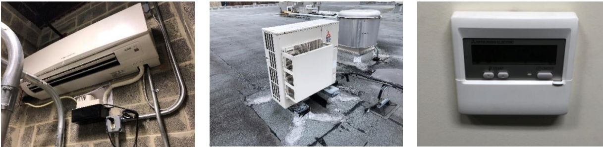
Ductless Mini Split System Heat Pump
