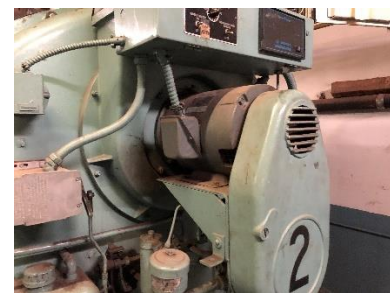
Combustion Air Fan
