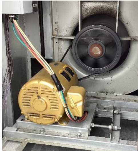
Supply Fan Motor
