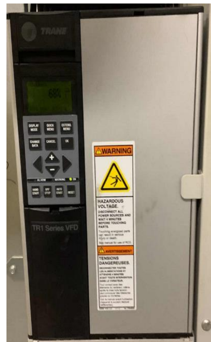
AHU-2A Motor VFD
