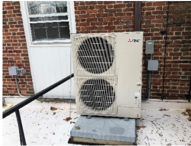
Ductless Mini Split Heat Pump
