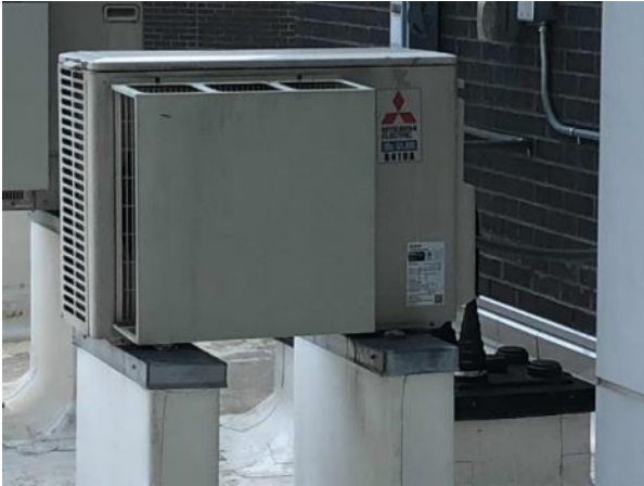
Ductless Mini Split System
