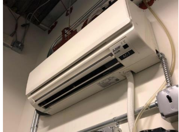
Ductless Mini Split System
