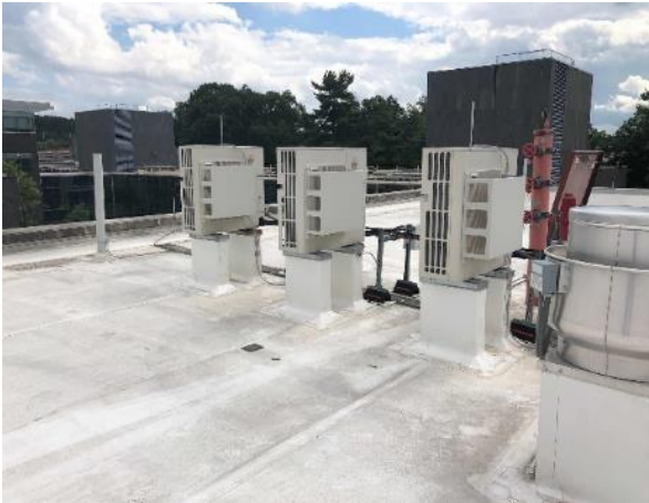
Ductless Mini Split Units
