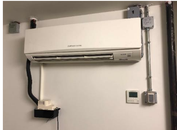
Ductless Mini Split Units
