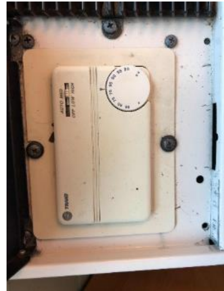
Fan Coil Unit Thermostat
