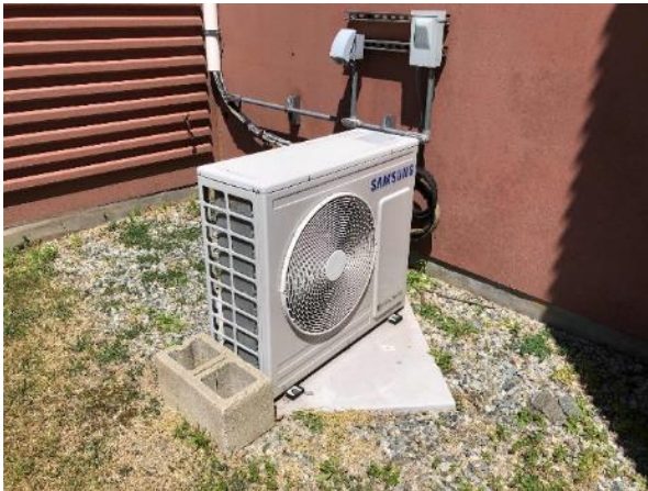
Ductless Mini Split Units
