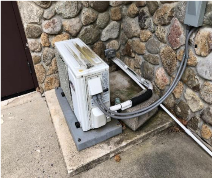
Ductless Mini Split Heat Pump System
