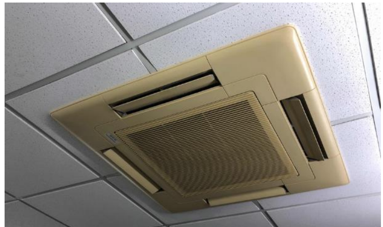
Ductless Mini Split Unit
