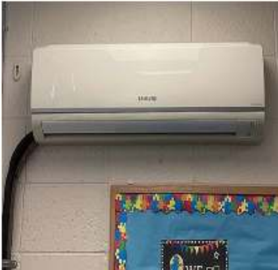
Mini Split Heat Pump – Evaporator
