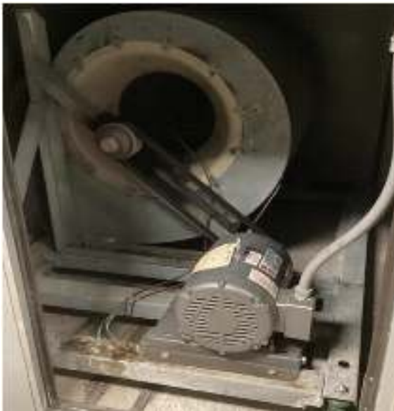
10 hp Supply Fan Motor
