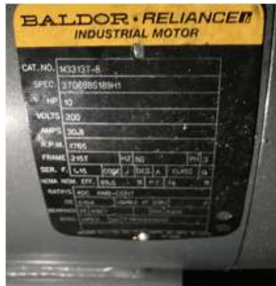
10 hp Supply Fan Motor
