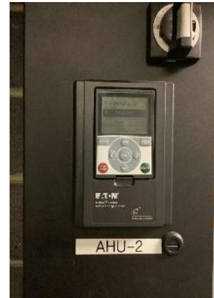
VFD- AHU 2
