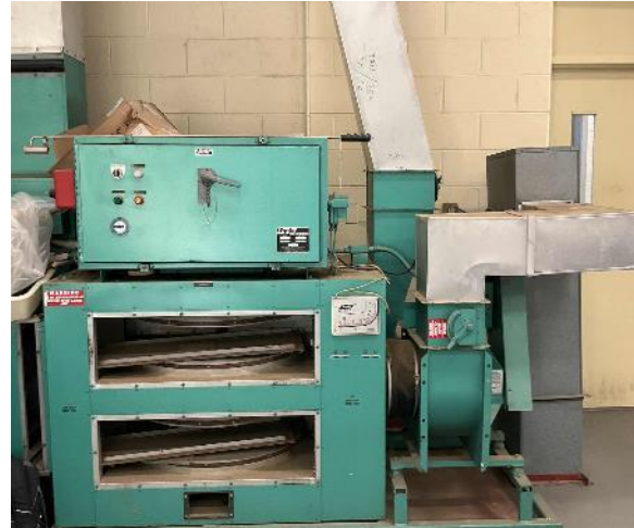
Dehumidifier: Nitrification Building
