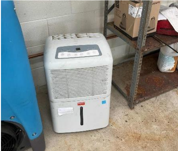
Dehumidifier: U.V. Building
