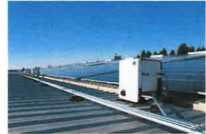
3 SMA STRING INVERTER PV1.0 SCALE: 1/8"
