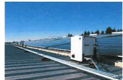
5 SMA STRING INVERTER SCALE: 1/8" = 1'-0"
