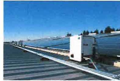
5 SMA STRING INVERTER PV1.0 SCALE: 1/8"
