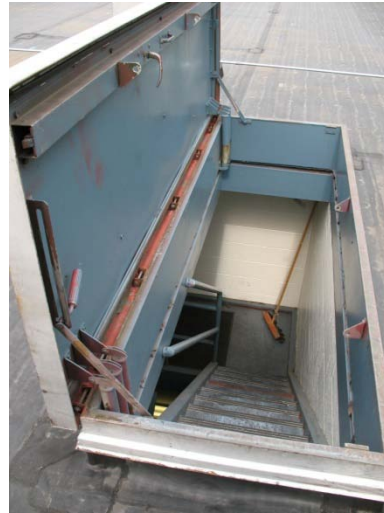
Roof access – metal-gasket door
