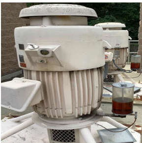
Clarifier Effluent Pumps
