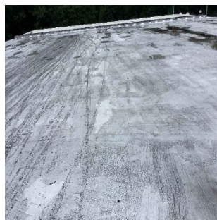
Roof – Rubber Layer
