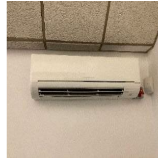
Ductless Mini Split Heat Pump
