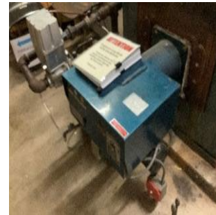
Combustion Air Fan
