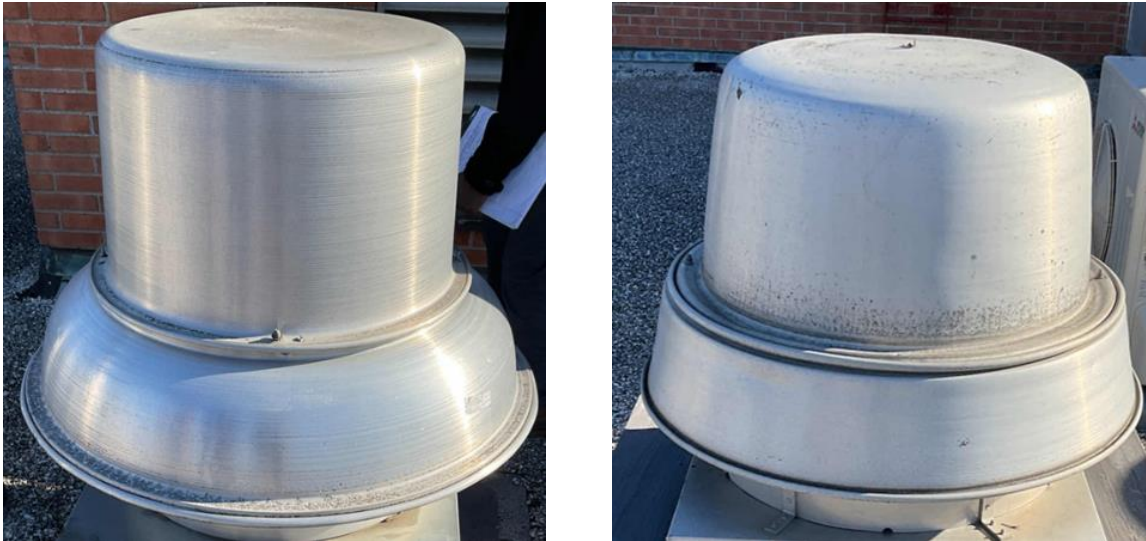
Typical Exhaust Fan & Kitchen Hood Fan
