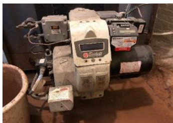
Combustion Air Fan
