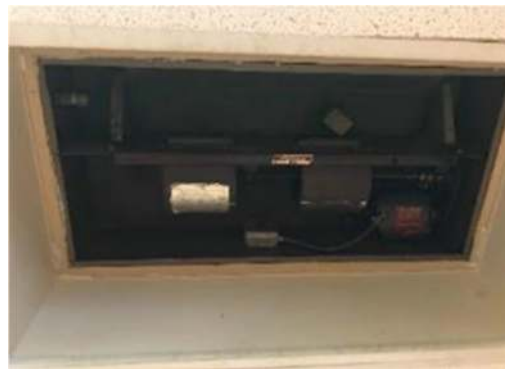
Corridor Fan Coil Unit
